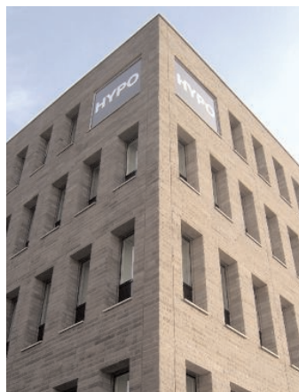
Solide wie die Geschäftstätigkeit der Hypo Liechtenstein: Das Verwaltungsgebäude.
